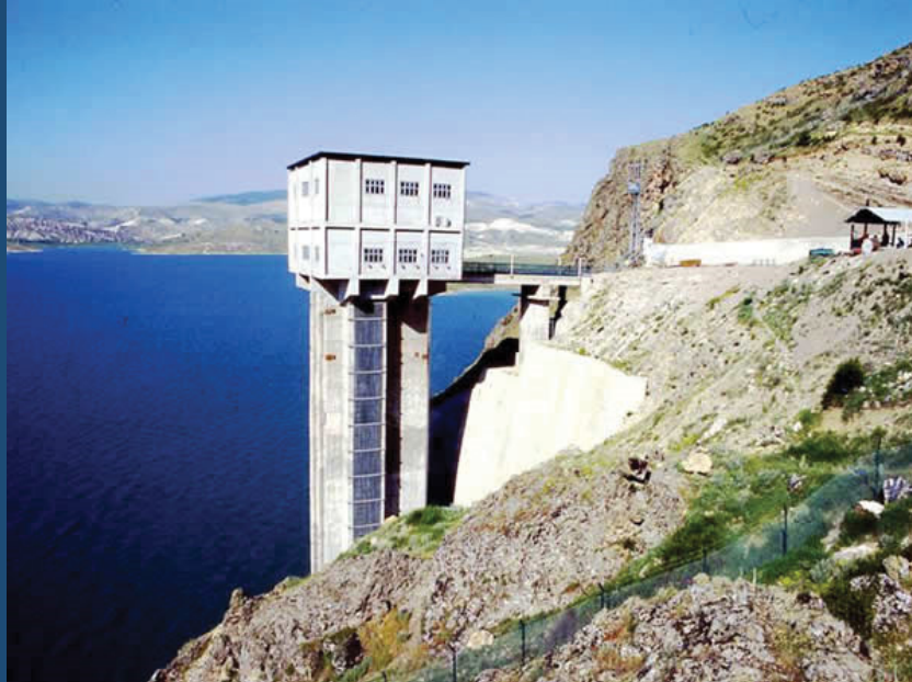
Çamlıdere Barajı Su Alma Yapısı (80 m yükseklik)
